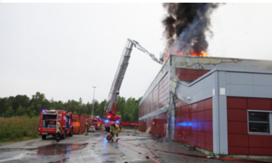
Figur 2 Brannen spredte seg via fasaden til taket. Foto: Bergen brannvesen.
