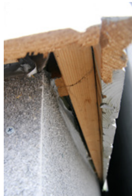
Dette er «brannveggen» mellom nr. 45 og nr. 43, med en avstand på 65 centimeter mellom husene. Det er gipsplater under trepanelet.
