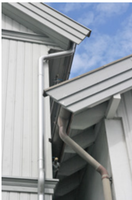
Det er skåret hull for å få plass til takrennen. Fasaden skal nå være sikret med et glykolanlegg.
