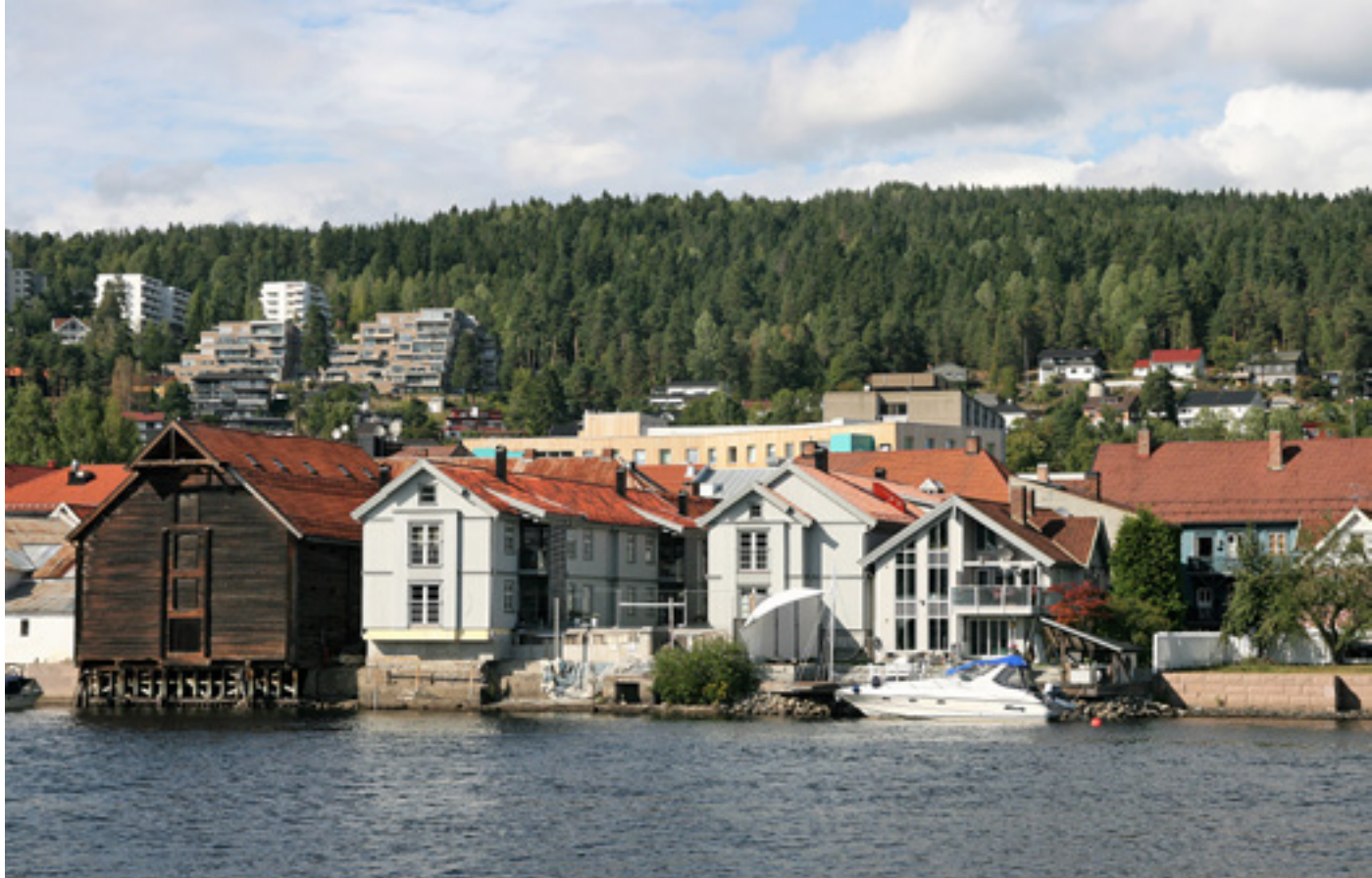
Og slik ser det ut i virkeligheten. Avstanden mellom husene er halvert, og høyden på nybygget er 1,80 meter høyere enn byggetillatelsen tilsier.
