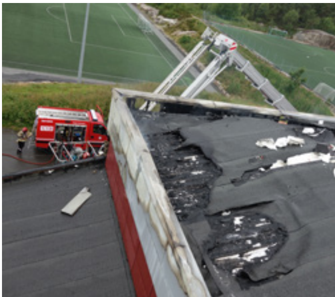
Figur 4 Brannvesenet satte straks i gang med å lage branngater for å hindre spredning i isolasjonen på taket. Foto: Bergen brannvesen
