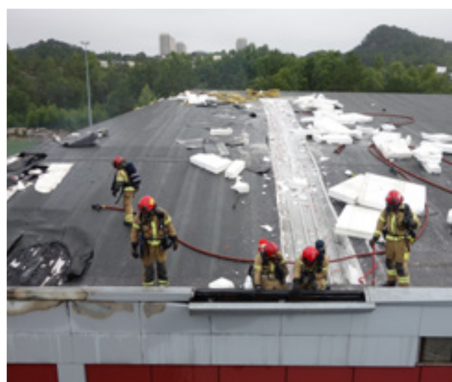
Figur 3 Til tross for at brannen fikk et godt tak i taket som var isolert med ekstrudert polystyren dekket med takpapp, greide brannvesenet å slokke brannen. Foto: Bergen brannvesen
