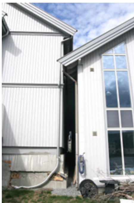
Nr. 45 er nærmest tredd innpå nr. 43. Det er «gode forhold» for påsatt brann mellom husene.
